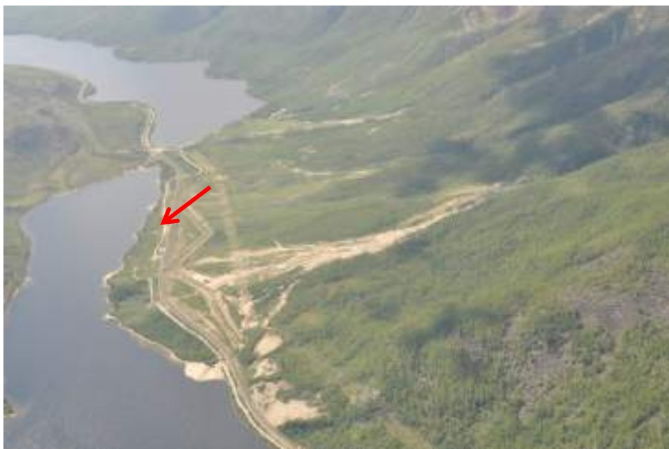
Рис. 11. б – общий вид инженерных сооружений – водонаправляющих канав, на участке перегона Кодар-Леприндо, на период 26 июля 2015 г.
