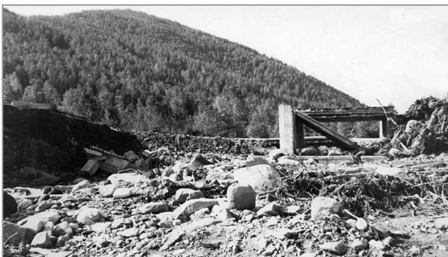
г – остатки моста на федеральной автодороге, первоначальной причиной разрушения стал оползень-сплыв, трансформировавшийся в сель, прошедший по р. Большая Куркавочная, (участок г. Слюдянка – г. Байкальск).
