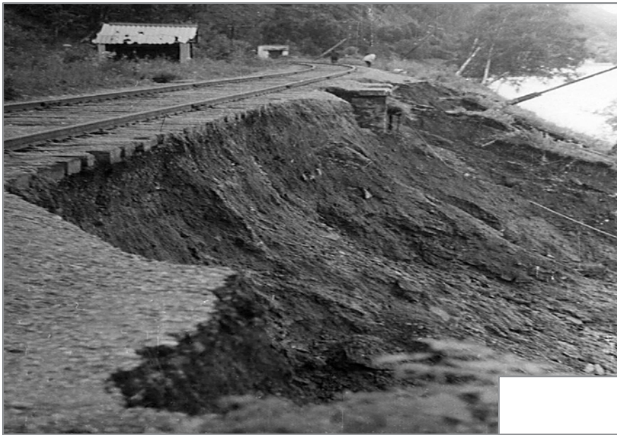
б – обрушение берега и второго пути железной дороги – результат оползня-сплыва;
