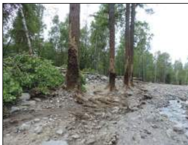
Рис. 2. Повреждения стволов лиственниц от пронесшихся в потоке воды деревьев. Селевое русло р. Первая Шихтолайка ( 51^{\circ}54'55.6'' , 102^{\circ}27'37.2'' ).
