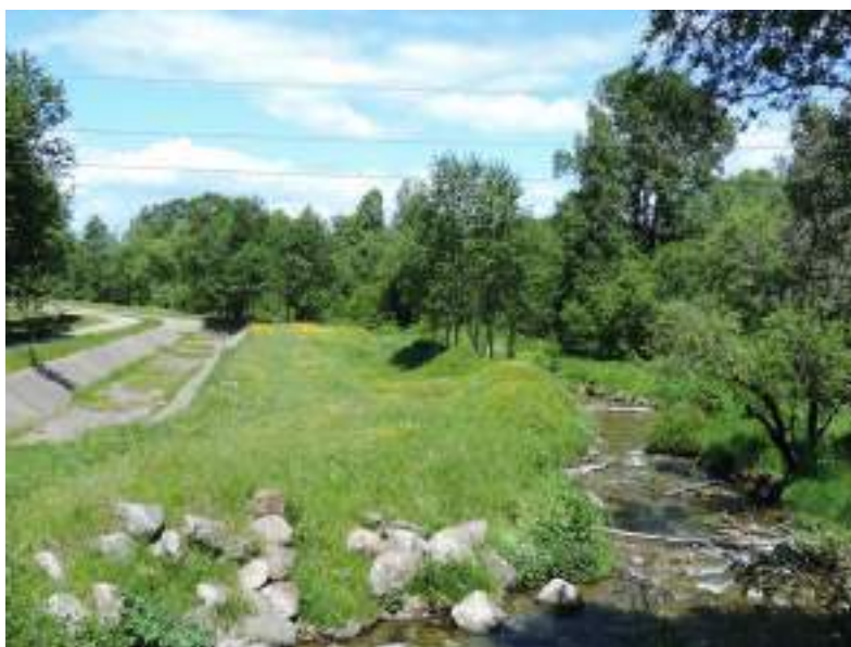
Рис. 5. Река Харлахта ниже автодорожного моста в районе г. Байкальска. Слева перехватывающая водоотводная канава. Фото 27 июня 2013 г. (51°31'23.6", 104°08'31.6").
