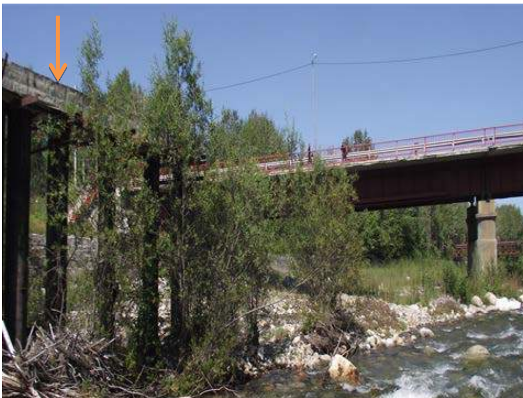
Рис. 4. Нарушенный автомобильный мост на р. Бабха был заменен. (Стрелкой показан фрагмент старого моста по Федеральной автодороге).
