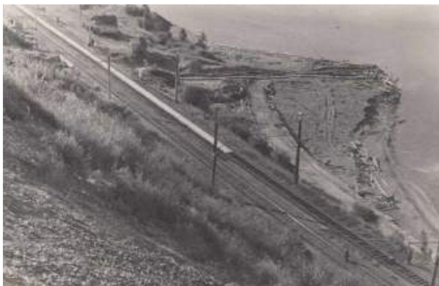
Рис. 2. Вновь образованный селевый конус выноса в устье лога Ямный на участке железной дороги ст. Байкальск – ст. Танхой (июль 1972 г.). Примечание: Белая полоса – это восстановленная часть дороги после полного разрушения.
