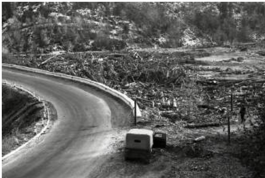
Рис. 1. Мощные грязекаменные селевые отложения с поваленными деревьями в русле ключа Галанский на участке автомобильной дороги г. Байкальск – п. Танхой (июль 1971 г.).
