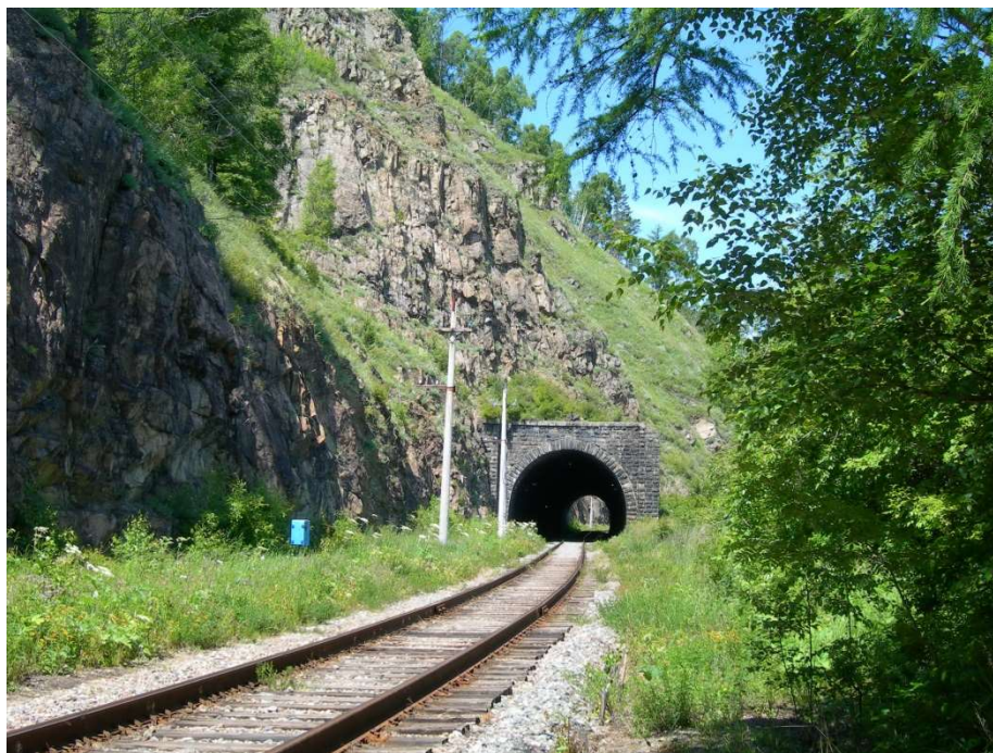
Рис. 11 – Фотография одного из тоннелей КБЖД
