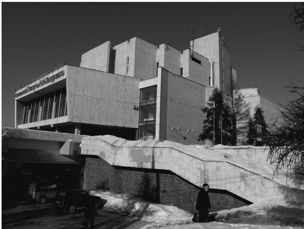
Общий вид здания музыкального театра им. Н.М. Загурского.
