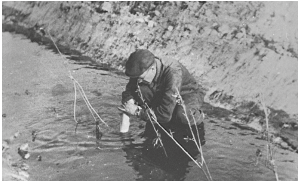
Во время работ по прокладке с помощью шнуровых зарядов осушительных каналов в пойме реки Ирмень
